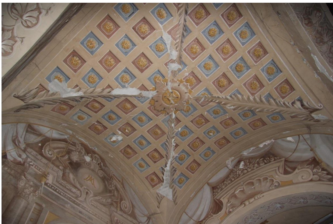
Fig.20: Particolare volta navata laterale crollata
